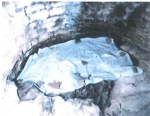
Vista del cobriment geotèxtil de l'absidiola lateral sud un cop finalitzada l'excavació, s'observa l'aflorament de la roca natural a on s'assenten les parets
