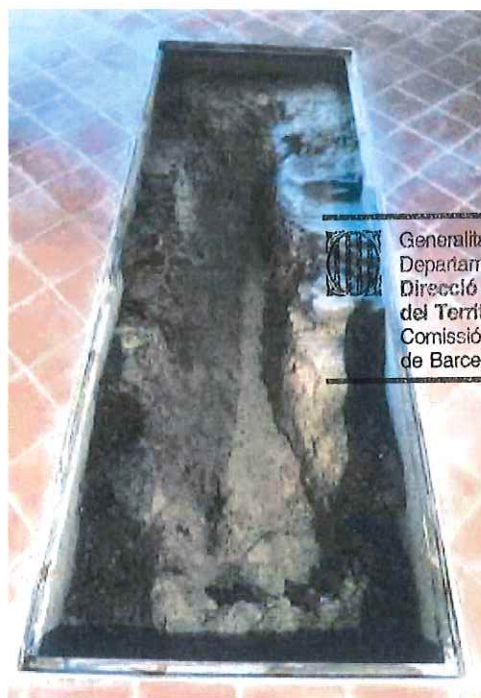
Vista del cobriment geotèxtil de l'absidiola lateral sud un cop finalitzada l'excavació, s'observa l'aflorament de la roca natural a on s'assenten les parets
